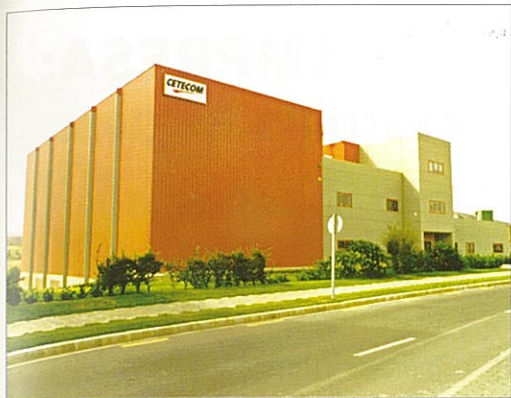
CETECOM: Proyecto. Dirección de obra. Ejecución. Llave en Mano
