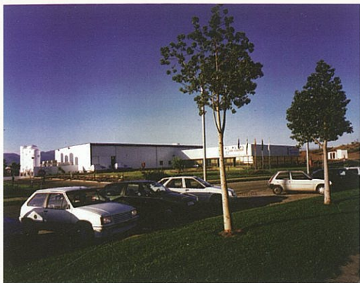
AIR LIQUIDE SEO Parque Tecnológico de Andalucía-Málaga
