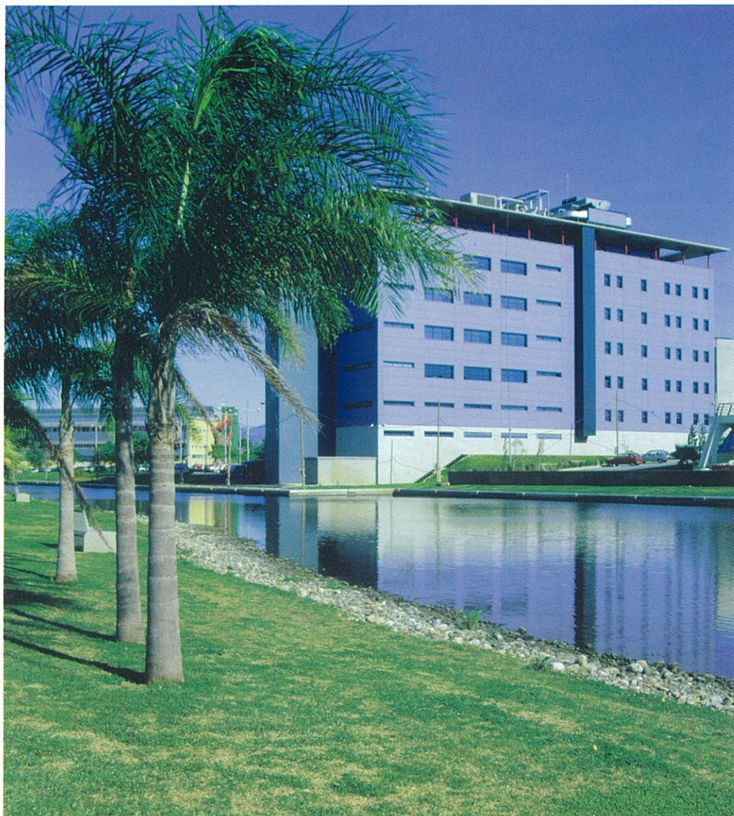
El edificio Institutos Universitarios acoge el CTI y la OTRI.
