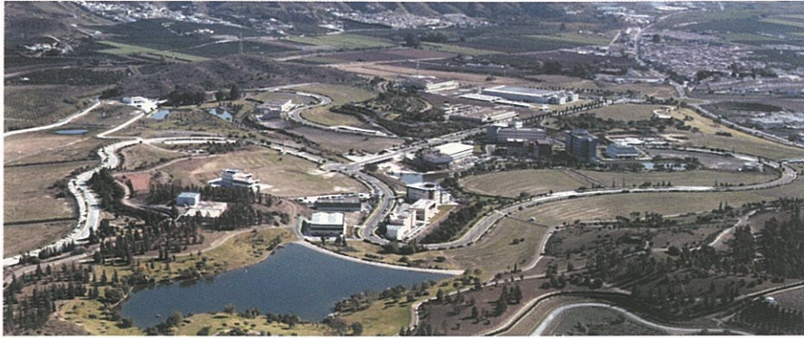
Vista área del Parque Tecnológico de Andalucía.
