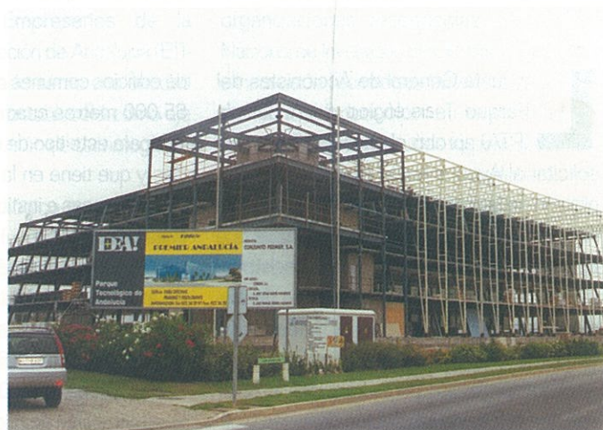
➤ Edificio del Conjunto Premier en su última fase de construcción.
