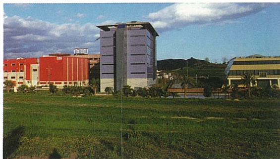
► Vista parcial del Parque Tecnológico de Andalucía
