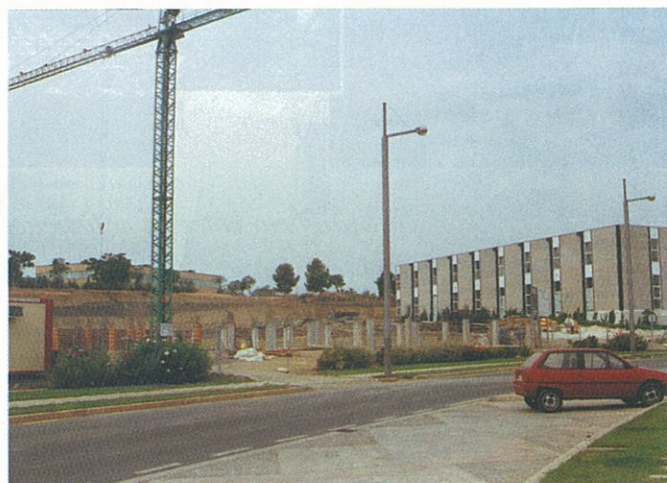
➤ Edificio Possibilia 2005 en el inicio de las obras.
