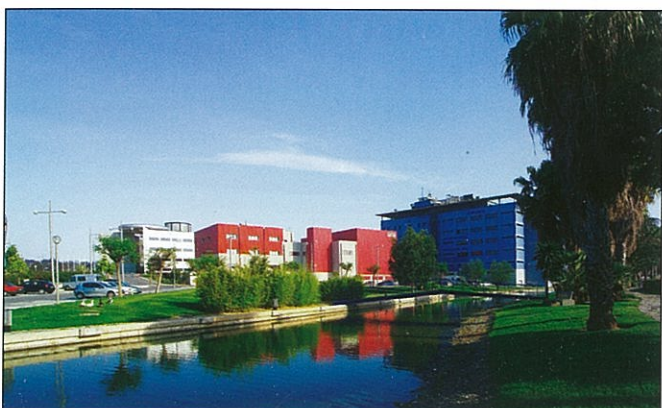
► Empresa GETECOM en el PTA.
