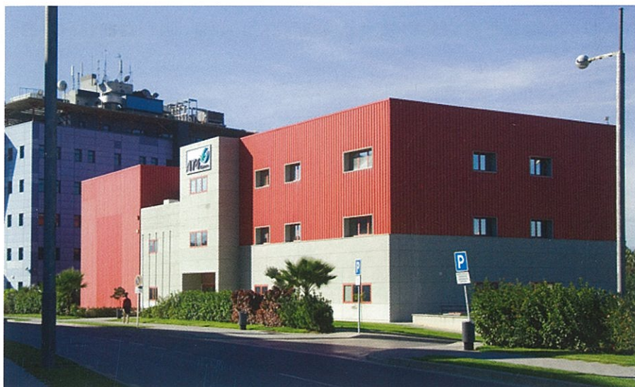
Una de las sedes de AT4 en el PTA.
