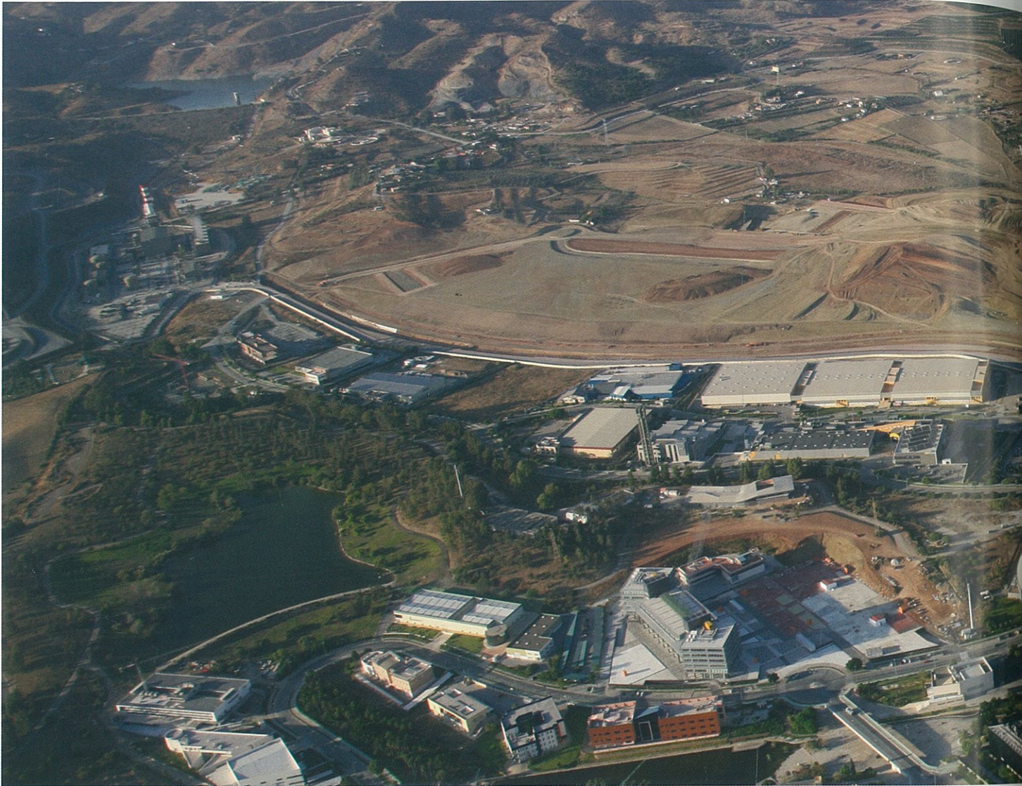
Imagen de las obras de la primera fase de ampliación del Parque Tecnológico de Andalucía, que supondrán un incremento de
