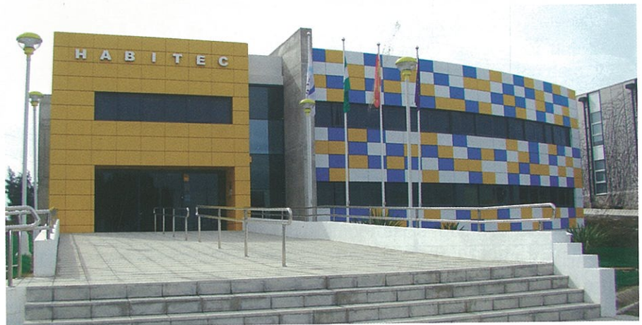
Imagen de la fachada de la Sede de la Fundación, en el Parque Tecnológico.
